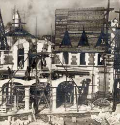
3. Maison cantonale en construction. ABM. Fi XXXI-H-2
