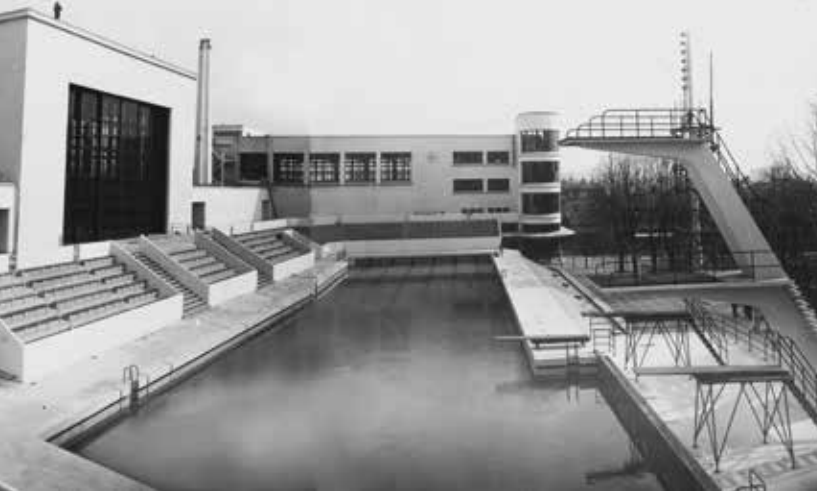
3. J. Sereni. Vue du bassin extérieur. 1935. ABM.Fi XIV-O-6
