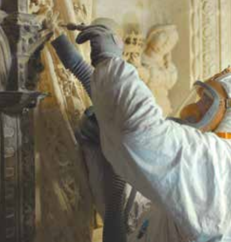
13. Restauration du retable de la chapelle Saint-Joseph
